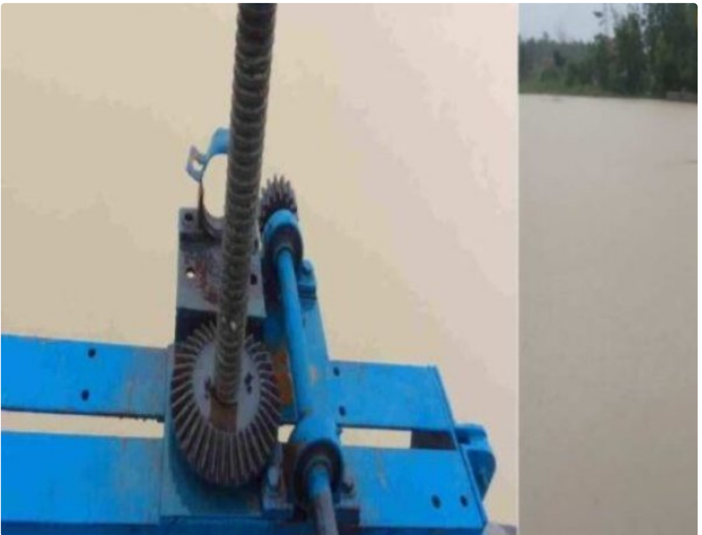
Pintu air Albaret Simpang Mesuji
